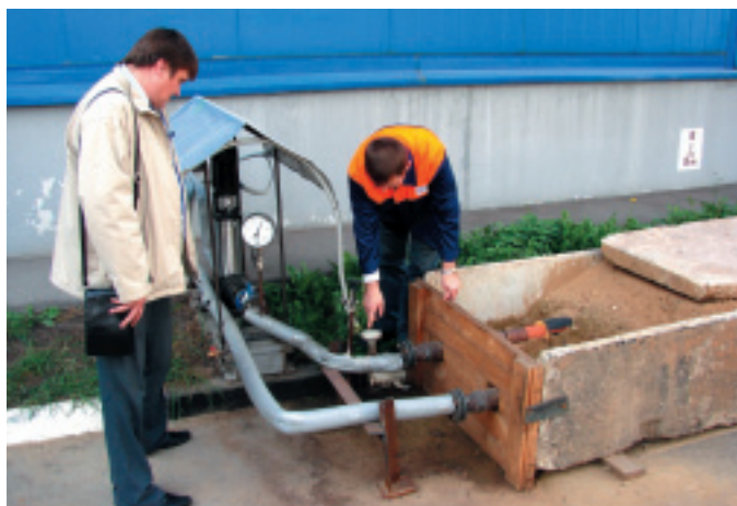
Рис. 4. Испытания труб ИЗОПРОФЛЕКС на полигоне РТЭС Люблино
